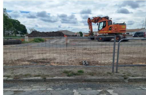
Aménagement de l'aire de jeux
